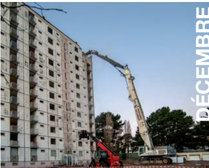
Démolition par grignottage du Trieux, bâtiment emblématique de 108 logements (Orvault-Plaisance)
