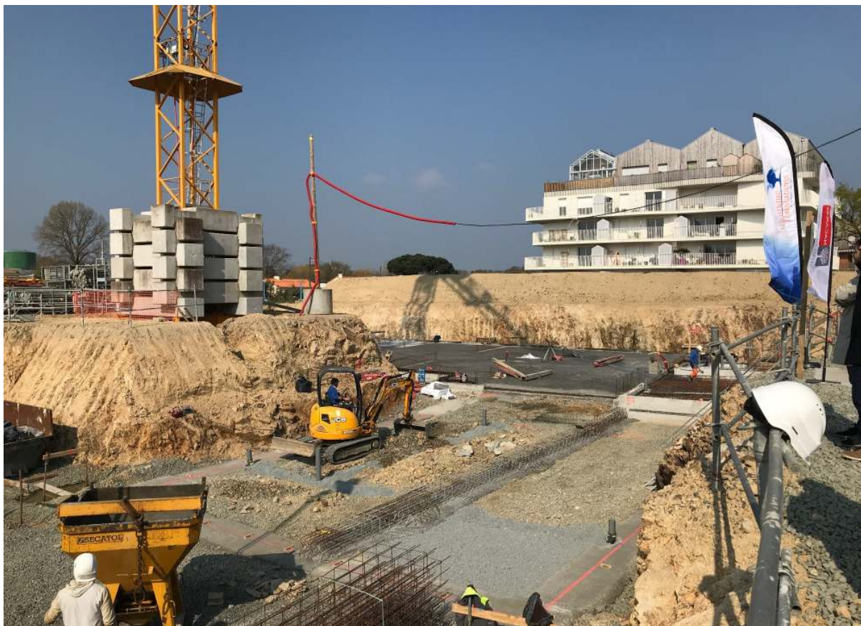
Quartier Jaguère à Rezé, construction de la résidence Saint-Ex' par promoteur Nacarat, associé à Atlantique habitations. | CRÉDIT PHOTO : OUEST FRANCE
